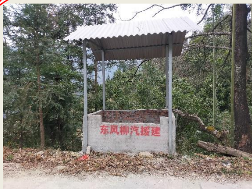
东风柳汽在大新村建设垃圾池
